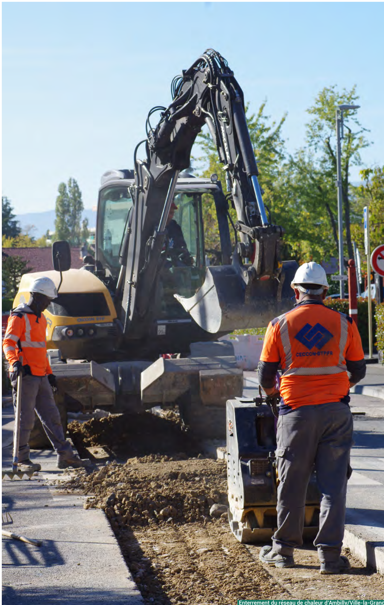
Enterrement du réseau de chaleur d'Ambilly/Ville-la-Grand
