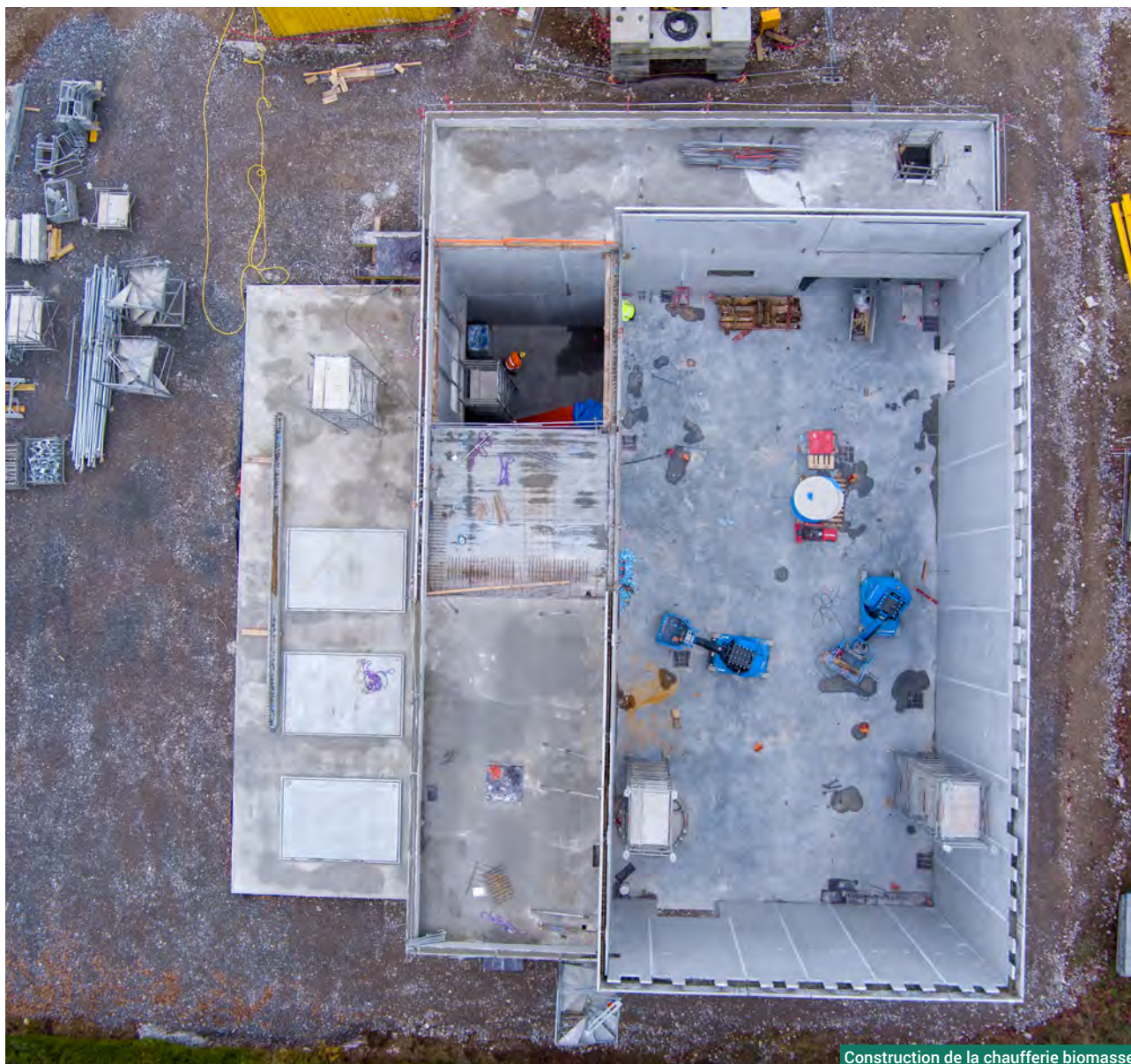
Construction de la chaufferie biomasse d'Ambilly/Ville-la-Grand
